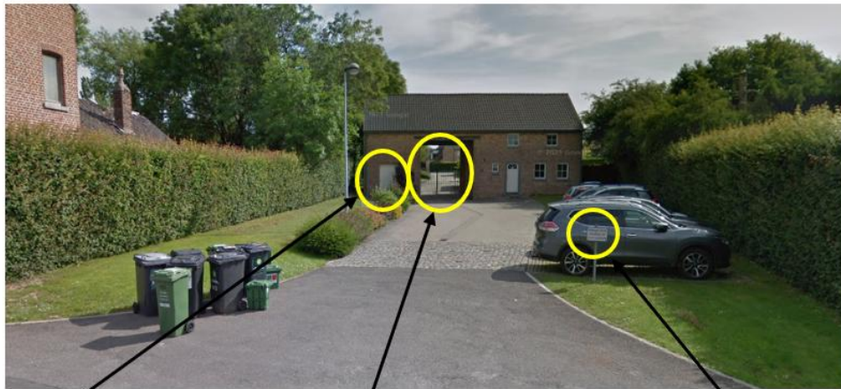
Local « poubelles » Portail avec ouverture contrôlée par les résidents + boîtes aux lettres Parking réservé aux visiteurs renseigné via panneau indicateur
